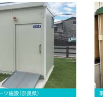
スポーツ施設(奈良県)
