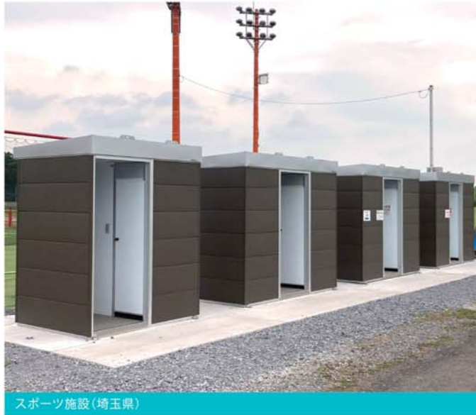
スポーツ施設(埼玉県)
