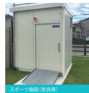
スポーツ施設(奈良県)
