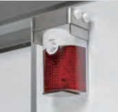
非常用報知器
