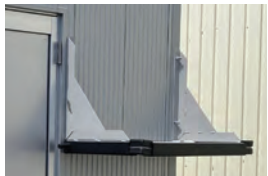
〔エアコン室外機架台〕
