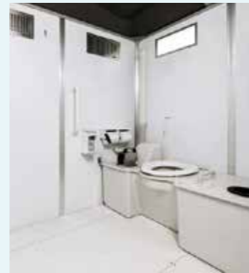
[室内/ポンプ式簡易水洗]
